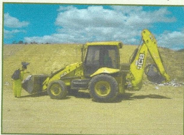
Figura 23 - Retroescavadeira (Belo Jardim)
