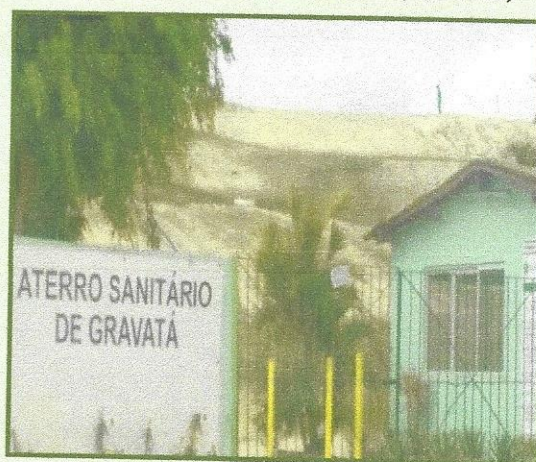
Figura 56 - Aterro sanitário (Gravatá)
